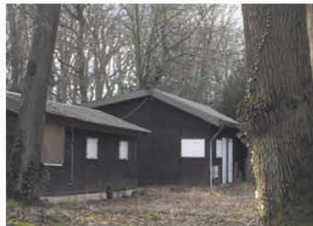
Un bâti à rénover.
