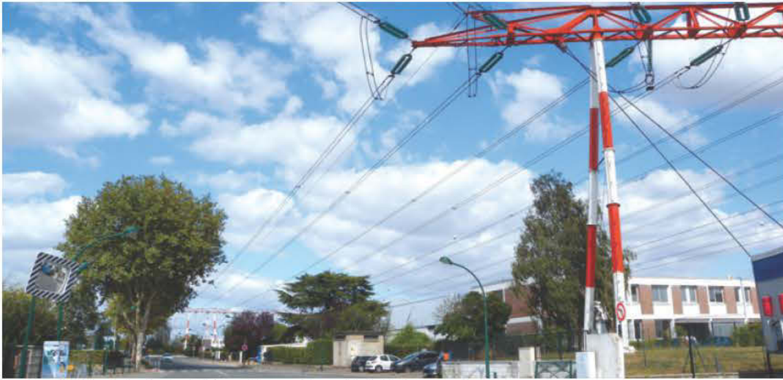
Une ligne à très haute tension inesthétique et bloquant les projets de développement.
