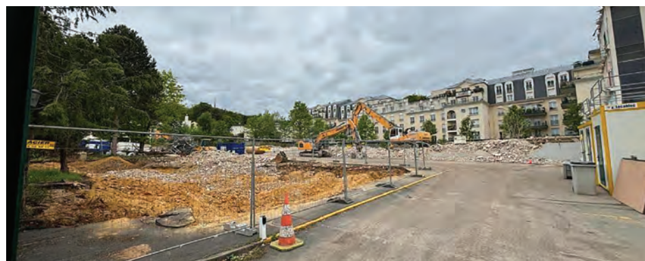
Le terrain de l'AFPA est dégagé de ses bâtiments.
