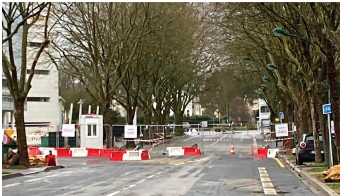
L'extrémité de l'avenue côté Clamart a été définitivement fermée.
