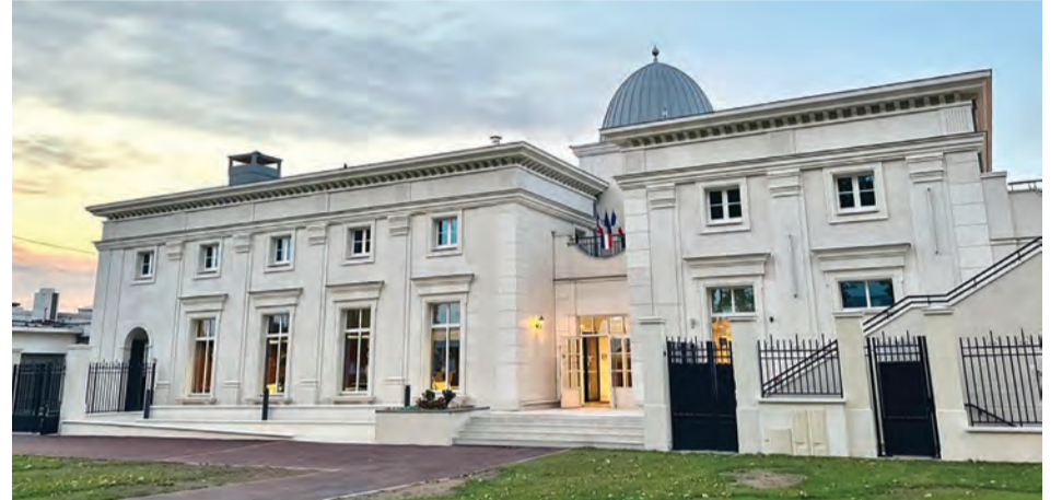
L'espace restaurant du Tennis club, installé au premier étage, va être exploité par une entreprise privée.
