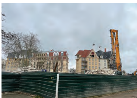
La partie Scène I est presque achevée, la démolition se poursuit.
