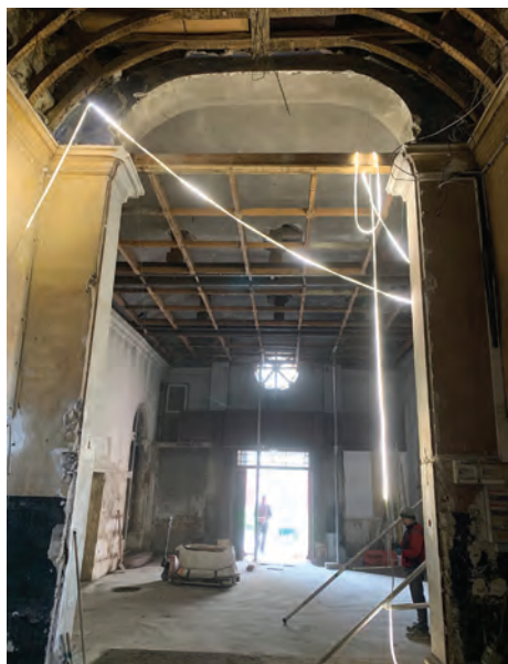
La nef et le plafond déjà dégagés.
