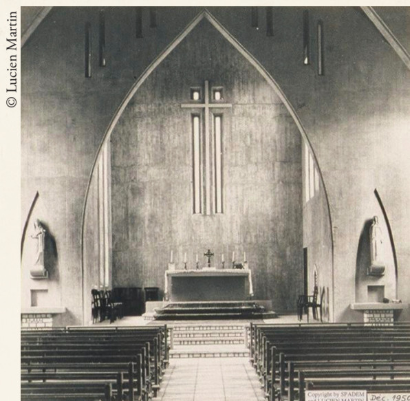
Le nouveau chœur édifié en 1950.
