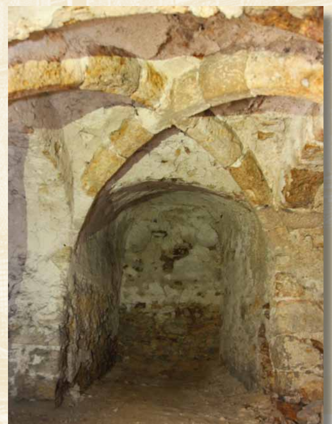
Voûte des caves du château.
