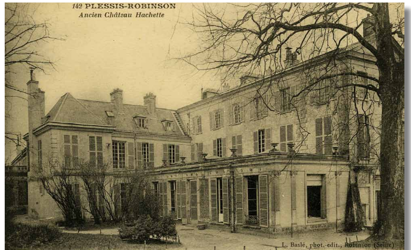
La façade Ouest du château vers 1920. Au premier plan l'extension de plain-pied voulue par Louis Hachette. À l'extrême gauche, on aperçoit l'extension en brique réalisée par son fils.
